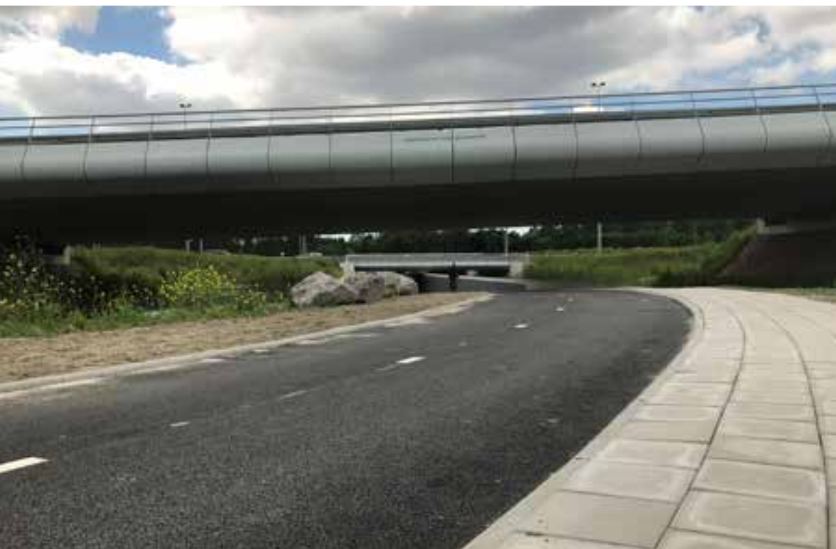
Diemberbos: Een 200 meter lange doorgang onder de A9, verbindt twee delen van het Diemberbos. De tunnel wordt gebruikt door wandelaars, fietsers en ruiters én dient als ecologische verbinding voor kleine zoogdieren en ringslagen (Foto: Staatsbosbeheer / Robert Graat)
